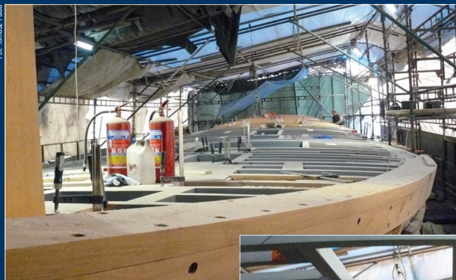
Remont Generała Zaruskiego trwa – tak wygląda z zewnątrz...
